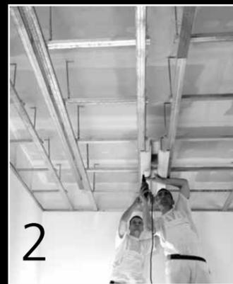
Einfach, schnell und sauber: Trockenbauer verschrauben den Gipskanal mit der Unterkonstruktion der Gipskartondecke.
