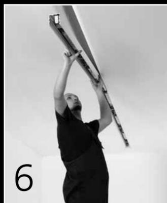
Passgenau: Die Leuchteneinheit wird vom Elektriker in den Gipskanal eingesetzt ...
