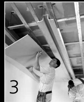
Die abgerundeten Kanalkonturen fügen sich randlos in die Gipskartondecke ein. Die verbleibende Wand / Decke wird mit Standard-Trockenbau-Platten verschlossen.
