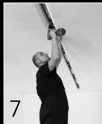
... und anschließend verschraubt und elektrifiziert.
